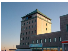
La sede di via Ferraris in esterno
